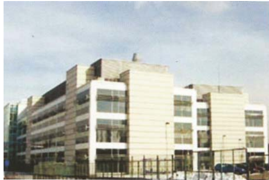
PLIVA Institut- Zagreb, keramičke ploče 90x 60 cm BWM potkonstrukcija ATK 102 Minor
