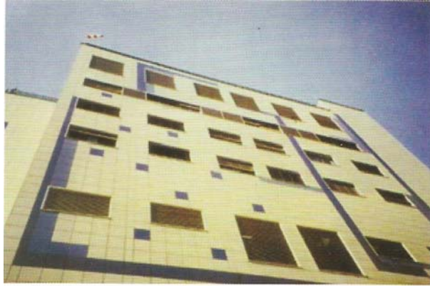
PLIVA Azitromicin - Novi Marof, keramičke ploče 60x 60 cm BWM potkonstrukcija ATK 102 Minor
