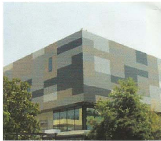
RIVA CENTAR, POREČ – keramičke ploče 300x100x0,4cm na BWM potkonstrukciji ATK 100 lijepljene na ljepilo Sika Tack Panel
