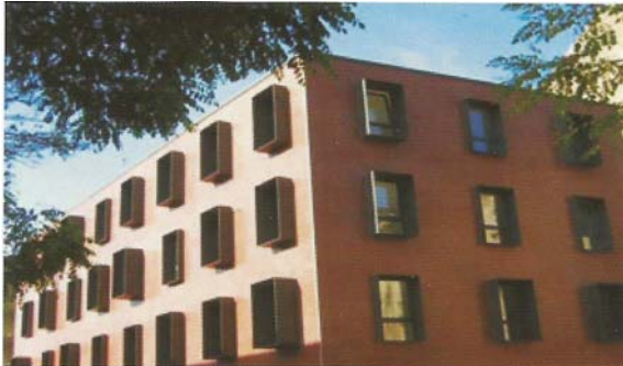
ZAGRAD II-Rijeka, stakleni mozaik 2x2 cm na Verotec pločama, BWM potkonstrukcija ATK 100
