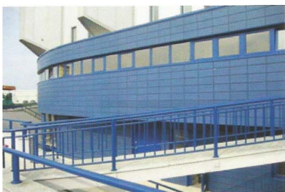
ŠRC VARAŽDIN - Varaždin, keramičke ploče 60x 30 cm BWM potkonstrukcija ATK 100KL
