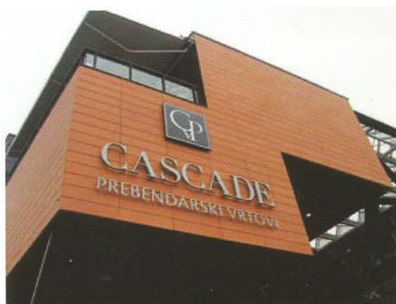
ZAGREB-Tkalčićeva ulica, NBK keramičke ploče 120x30x3 cm na BWM potkonstrukciji ATK 102 MINOR
