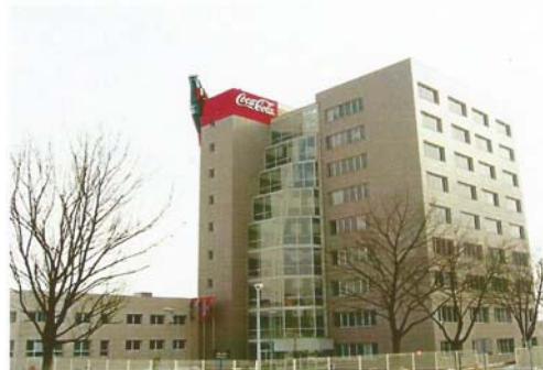
COCA COLA - Zagreb, keramičke ploče 60x90 cm BWM potkonstrukcija ATK 102
