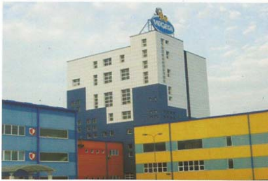
VEGETA - Koprivnica, keramičke ploče 90x60 cm BWM potkonstrukcija ATK 100KL
