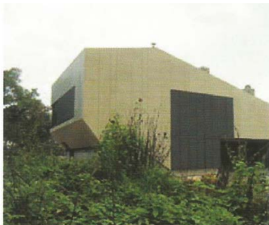
VILA MATULJI – kamene ploče Avorio četkan dimenzije od 30x50cm do 90x85cm na BWM potkonstrukciji ATK 102 Minor
