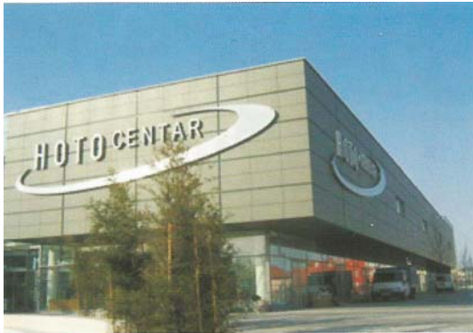
HOTO CENTAR - Sv. Nedelja, keramičke ploče 120x60 cm BWM potkonstrukcija ATK 100KL
