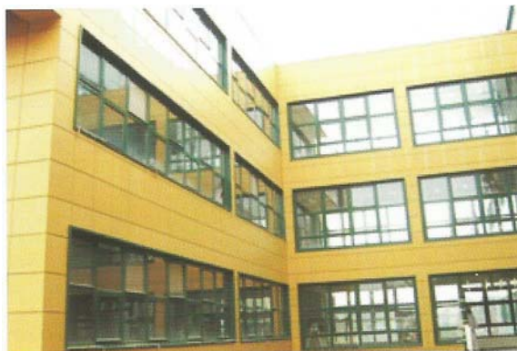
ŠUMARSKI FAKULTET -Zagreb, keramičke ploče 60x 60 cm BWM potkonstrukcija ATK 100KL
