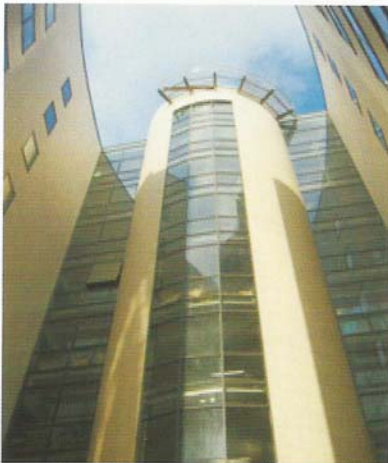
GRAND CENTAR- Zagreb, keramičke ploče 60x 60cm BWM potkonstrukcija ATK 100KL
