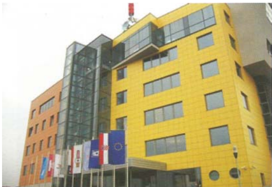
OBITELJSKI RADIO - Zagreb, keramičke ploče 60x60 cm BWM potkonstrukcija ATK 100KL
