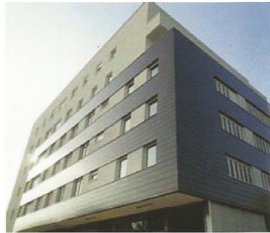
VMD STAMBENI OBJEKT VRBANI – Moeding ploče 120x30x3cm na BWM potkonstrukciji ATK 102 Minor
