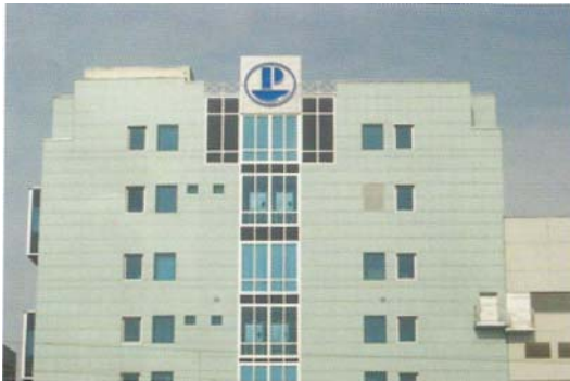
PLIVA Oralni oblici - Zagreb, keramičke ploče 60x 90 cm BWM potkonstrukcija ATK 102 Minor
