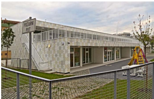
Dječiji vrtić "Vrbani" AL – puzzle 40x40x3mm BWM potkonstrukcija ATK100 Ljepljenje SikaTack panel ljeplilom
