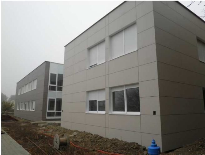
Dom zdravlja, Osijek – Levantina ploče 3 x 1 m lijepljene Bostik ljepilom na BWM potkonstrukciju ATK 100
