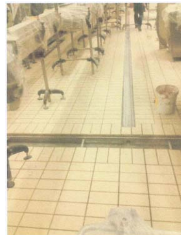
Postava novih odvodnih kanala
