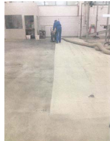
Čišćenje podloge sačmarenjem
