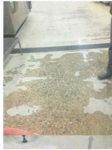
Betonska površina prije sanacije
