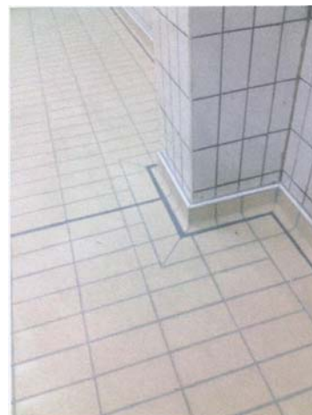
Izvedeno opločenje sa holkerima i dilatacijskim fugama
